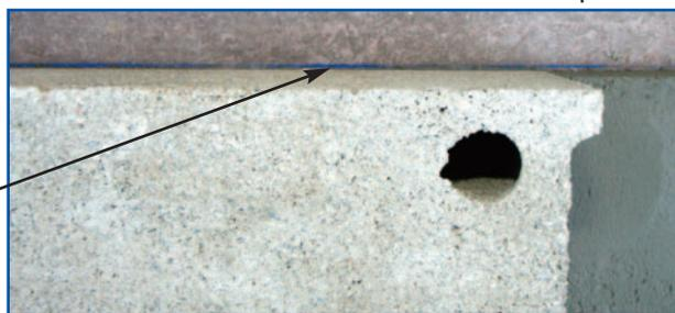
Le gabarit à joint GB3000 permet de réaliser des joints de mortier d'une forme régulière et d'une épaisseur constante. Des patins facilitent le déplacement du gabarit par glissement sur une fondation ou un plancher béton.
