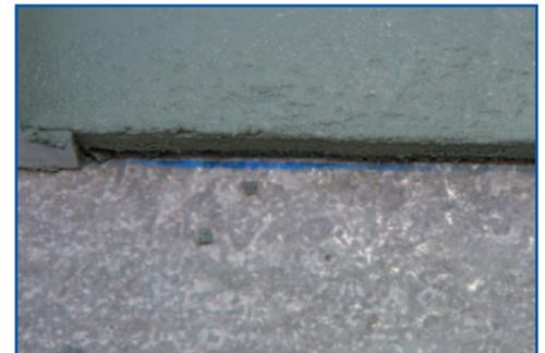
La réalisation du joint n'efface pas les traits préalablement tracés au cordeau. La pose du bloc est donc facilitée grâce à ces traçages restants visibles (avant le tapement du bloc).
