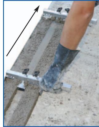
Le gabarit pourra être équipé d'une plaque pentue non débordante (option voir: GB3000) pour la réalisation d'une première rangée de blocs sur le bord d'un plancher ou le long d'un joint de dilatation avec ou sans la barre centrale.
